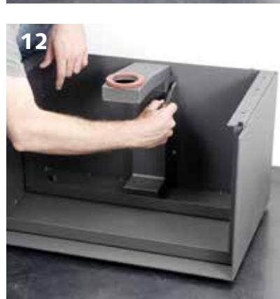
Plaats het onderstel op zijn poten indien dit nog niet is gebeurd. Zet het onderstel op zijn definitieve plaats. Controleer de veilige afstand ten opzichte van brandbare materialen. Voor de afstand aan de voorkant, zie de installatiehandleiding van de Stûv 16-cube.
