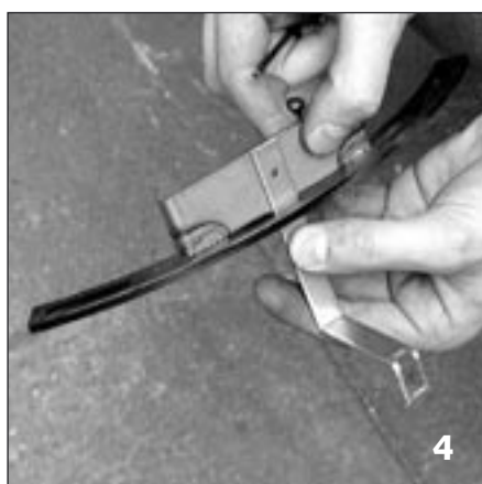
4 Retirer le registre par l'intérieur du foyer et sa commande par l'extérieur.
