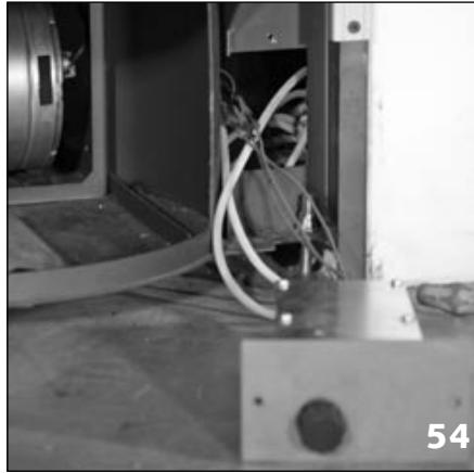
De Festonstekkers van de ventilator met deze van de schakelkast verbinden.
